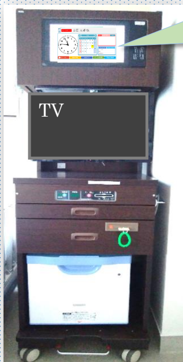
床頭台上部に設置
